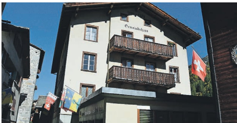
Das alte Gemeindehaus von St. Niklaus wird saniert.
