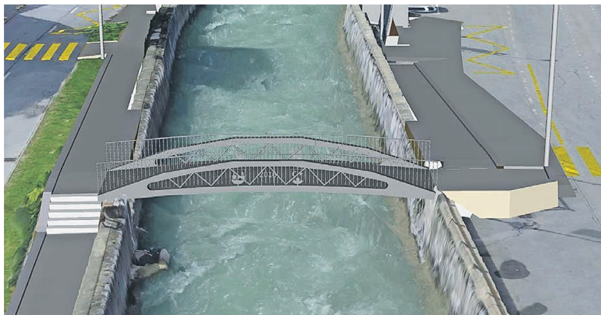
Die neue Fussgängerbrücke über die Lonza.
