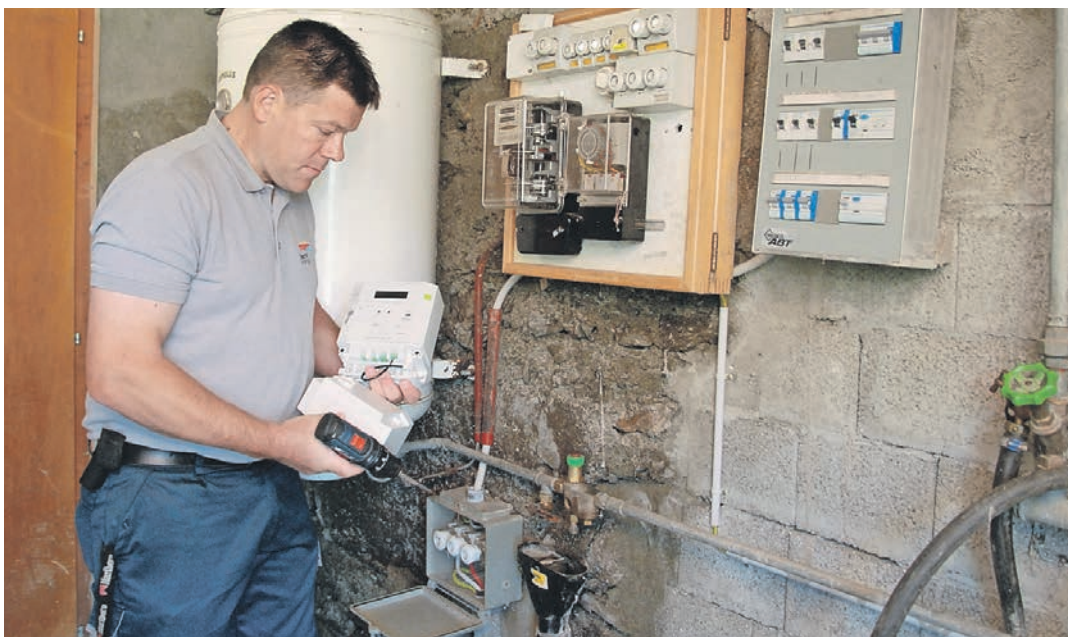
Zählermonteur Martin Hutter ersetzt einen mechanischen Stromzähler durch den neuen Smart Meter.
