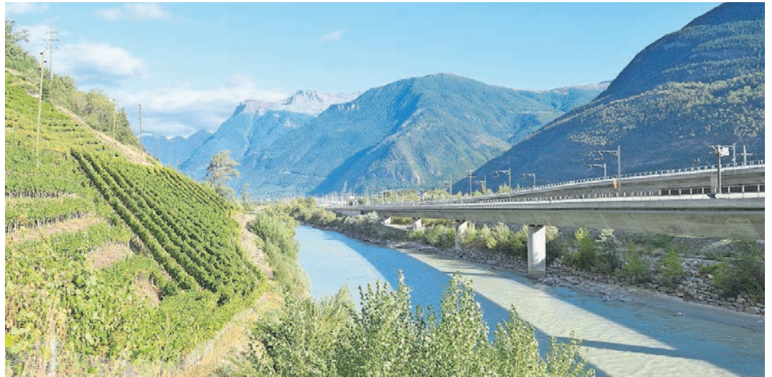
Der Wanderweg zwischen Baltschieder und Raron ist nördlich des Rottens geplant.
