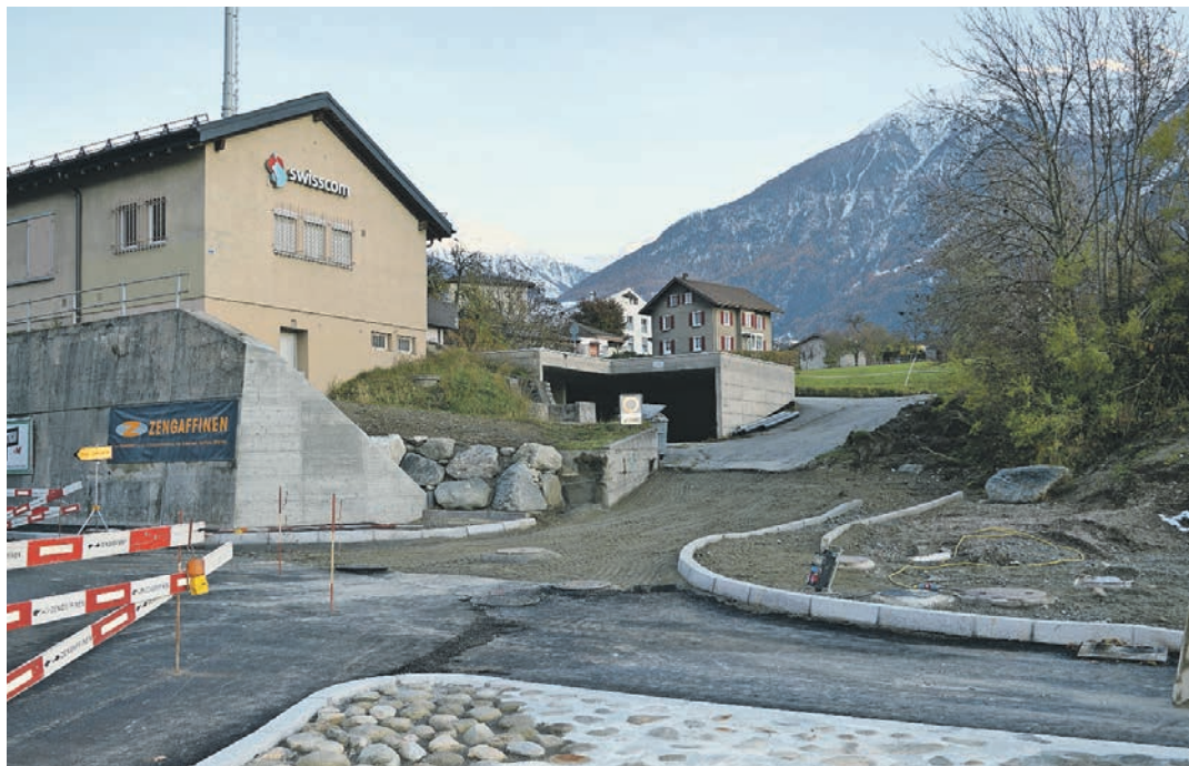
Den Anschluss Mattenstrasse zahlt die private Bauherrschaft.
